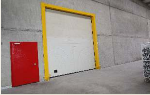
Endüstriyel Kapı; Farklı endüstriyel yapılara uygun, değişik ihtiyaçlara cevap verebilen tavana açılır sekiyonel kapılar.
